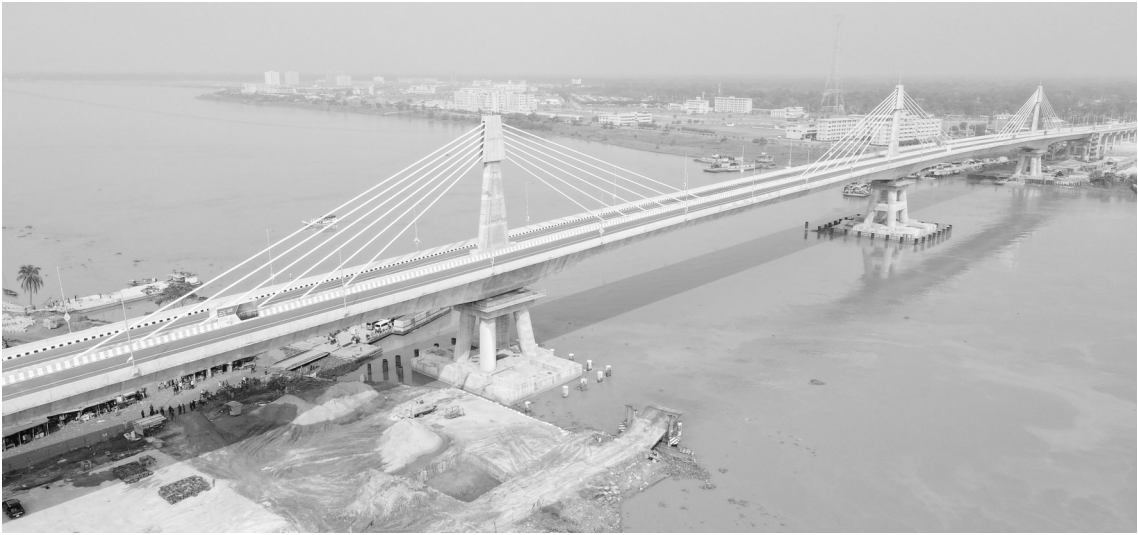
这是10月24日在孟加拉国博杜阿卡利拍摄的帕亚拉大桥。由来自中国的龙建路桥股份有限公司承建的孟加拉国帕亚拉大桥日前正式通车。 新华社发
