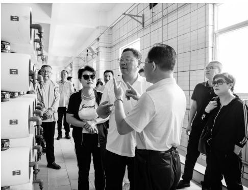
在中宁县第一污水处理厂，调研组现场了解近年来该污水处理厂取得的成效。
