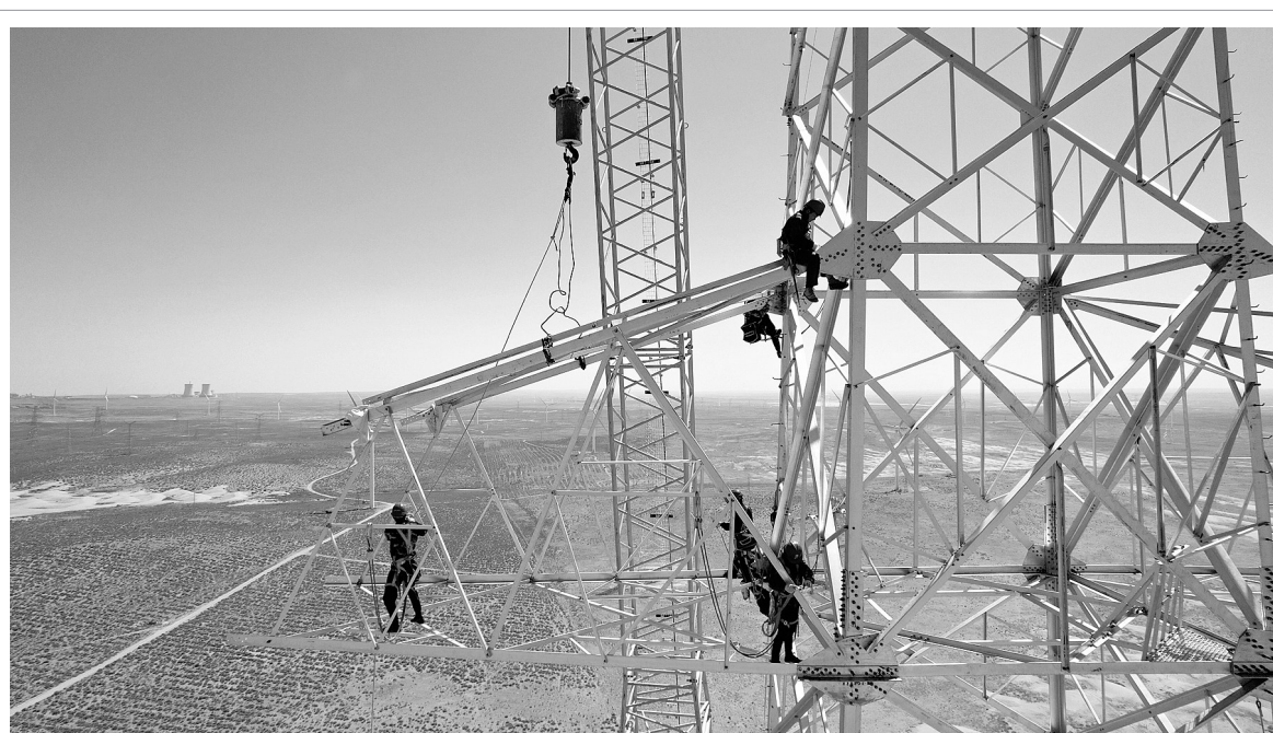
8月9日,随着最后6组导线横担吊装安装完成,西北最高的750千伏输电线路两座耐张塔组立工程全部顺利完成。
