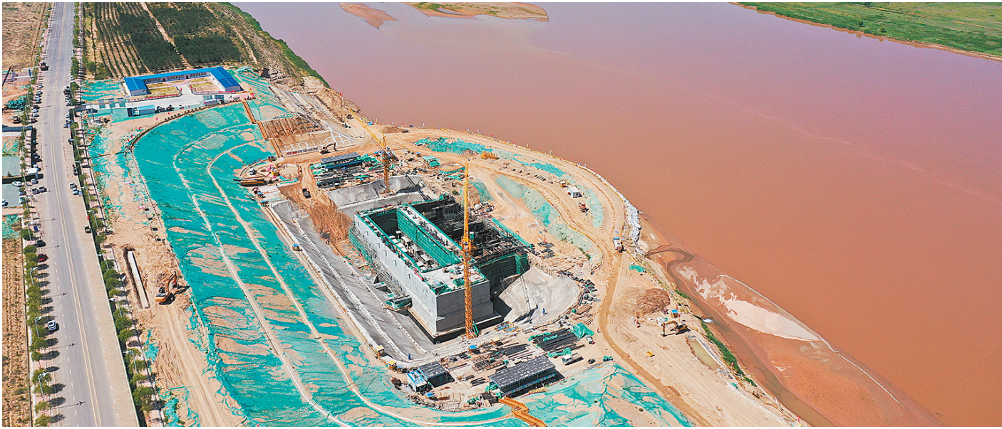
7月13日，记者俯拍银川市都市圈中线供水工程泵站建设项目。 银川市都市圈中线供水工程日前顺利完成泵站封闭圈主体浇筑施工任务，标志着泵站正负零以下主要构筑物施工取得阶段性胜利，为泵站主副厂房的施工奠定了基础。银川市都市圈中线供水工程将提升灌溉供水保障水平，提高水资源利用效率和效益，对解决银川市、石嘴山市黄河以东地区的生产生态取水 and 高质量发展具有重要意义。 本报记者 陈治学 摄
