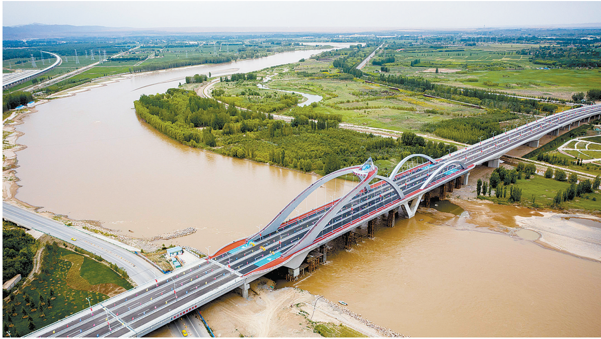
6月28日拍摄的中卫卫民黄河大桥（无人机照片）。当日，中卫卫民黄河大桥建成通车。该桥位于黄河中卫段，是宁夏境内第18座跨越黄河的公路桥梁。新华社记者 杨植森 摄
