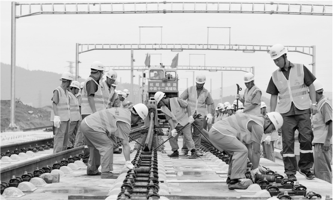
6月22日,中铁十一局的施工人员在杭绍台铁路上进行铺轨作业。当日,在杭绍台铁路温岭站施工现场,随着最后一根钢轨平稳在无砟轨道上铺设到位,我国首条民营控股高铁杭绍台铁路全线铺轨贯通,为年底开通运营奠定基础。杭绍台铁路连接浙江杭州、绍兴和台州三地,线路设计时速350公里。
