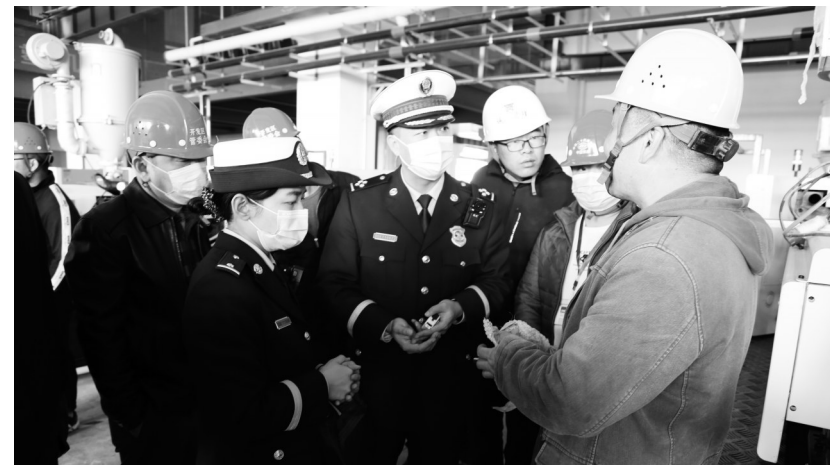
近日,银川开发区消防救援大队在辖区开展消防产品质量专项检查工作。针对检查中发现的不合格消防产品,依法下发了《消防产品现场检查判定不合格通知书》《责令限期改正通知书》,要求场所负责人立即更换不合格消防产品,定期检查消防产品是否完好有效。该大队将严格按照“发现一起,查处一起”的原则,严厉查处制售假冒伪劣消防产品违法行为。通讯员 雍丽媛 高雪婷 摄
