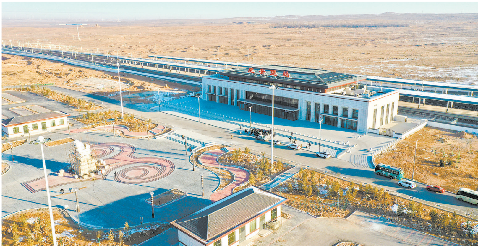
银西高铁宁夏东大门——惠安堡站。
