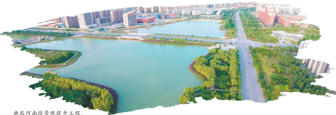
典农河南段景观提升工程。
