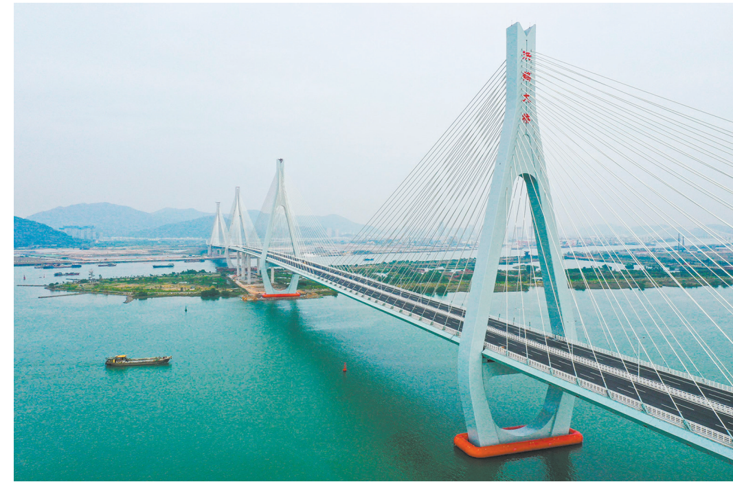
位于珠江口磨刀门水道的鹤港高速洪鹤大桥(12月9日摄, 无人机照片)。 由中铁十一局施工的珠海鹤港高速公路全长35公里, 东起港珠澳大桥连接线, 西至珠海鹤洲岛, 远期对接江门黄茅海。项目全线设置7处互通立交、18座(特)大桥和两座隧道, 桥隧比达89.7%。项目建成后将成为珠江口两岸地区快速对接粤港澳大湾区的主通道。 新华社发
