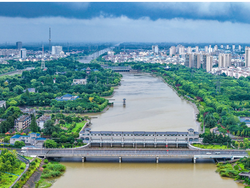
8月11日拍摄的位于江苏省扬州市江都区的南水北调东线源头江都水利枢纽西闸（无人机照片）。
