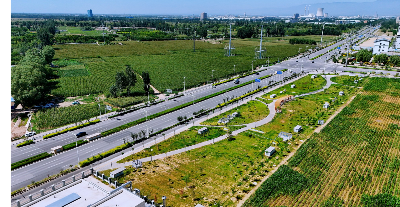
8月3日,金凤区南部排水系统调蓄水池建设工程现已全面完工并投入运行。项目创新打造“地下调蓄水池、地上小微公园”立体空间模式,持续为银川海绵城市建设注入新动能。目前,该项目整套设施已具备稳定进出水运行条件,能够有效提升金凤区南部排水系统雨水滞蓄能力,削减降雨峰值流量,缓解汛期下游第七污水处理厂运行负荷,可保障区域遭遇1小时18毫米降雨时雨水不外排,有效防范城市内涝风险。
