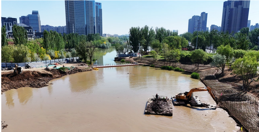
5月6日，在银川典农河，大型机械在进行补水口淤泥清除、生态缓冲带修复。据了解，典农河水生态修复工程由东到西涉及丽景北街至宁安北街河段，计划于6月底完成基本建设部分。该工程将布设10处生态潜岛，清除陈休渠至尹家渠段河道淤泥，在岸坡种植12万平方米的金叶榆、连翘、四季玫瑰、五彩小菊等植物。 本报记者 陈治学 摄
