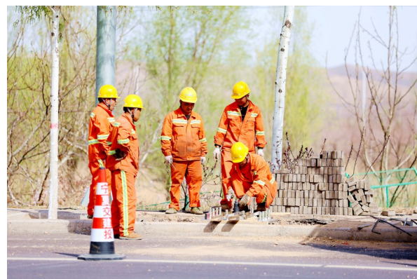
在灵武市某施工现场,修路工人精心组装修路设备。
