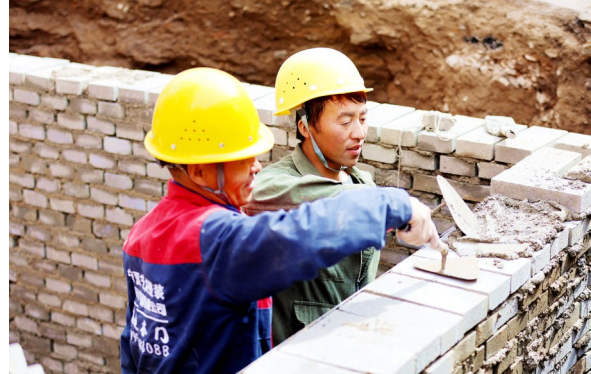
在兴庆区某建筑工地,务工人员埋头砌墙作业,用汗水筑牢城市根基。
