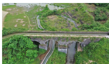
巨丰堰、永丰堰与平江河支流在三拱桥渡槽处呈立交分布。
