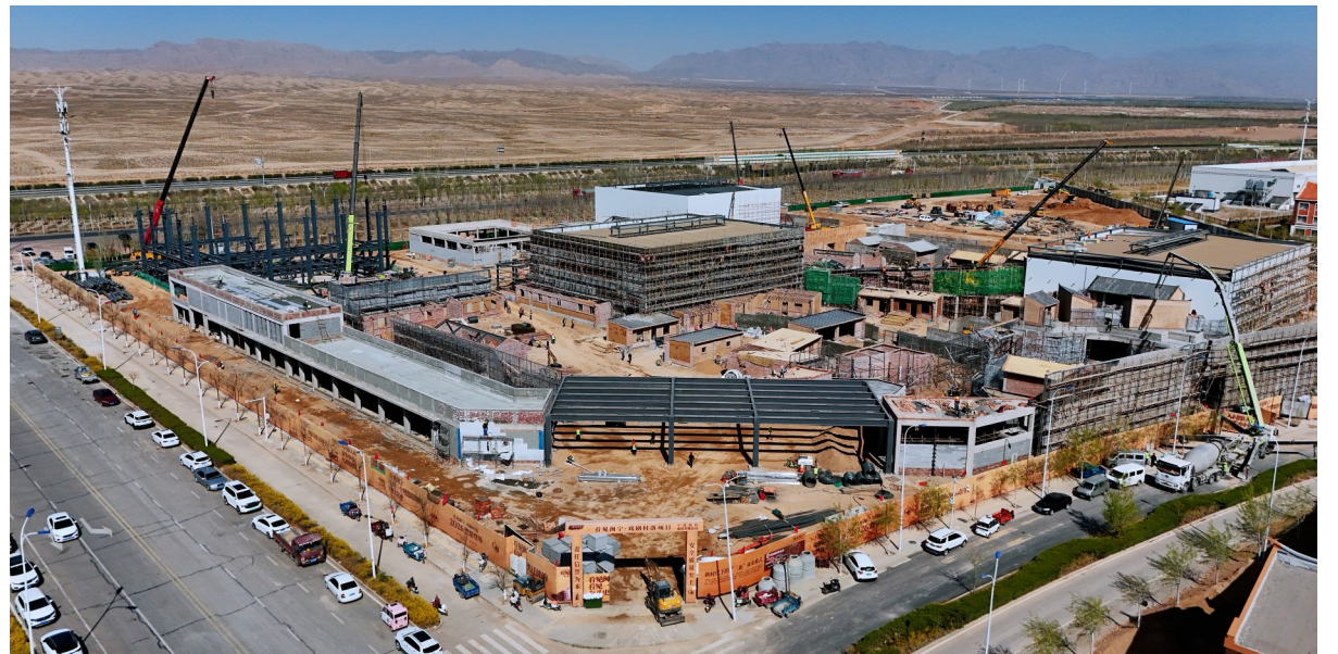
4月7日,《看见闽宁·戏剧村落》项目施工现场一片火热,各项施工作业紧锣密鼓、高效衔接,整体工程正按照既定目标稳步推进。 作为闽宁协作30周年重点文旅工程,该项目建成后,预计可带动闽宁镇及周边群众直接就业500人、间接就业2000人。运营前期,年接待游客量预计突破30万人次,成熟运营后将超过100万人次,预估带动综合消费超10亿元。 本报记者 陈治学 摄
