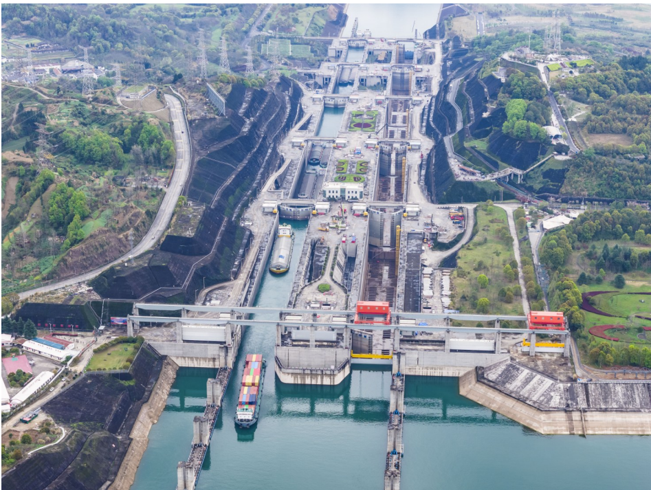
3月30日，湖北宜昌，三峡枢纽南线船闸正加紧检修，北线船闸有序通航(无人机照片)。三峡南线船闸2026年计划性停航检修于3月4日开工，计划工期45天，目前施工进度过半。检修期间，三峡枢纽通航保障有力，各类重点急运物资有序过坝。新华社发
