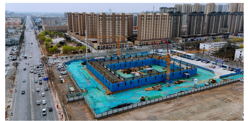
3月31日,位于西夏区贺兰山路以南的贺兰山全民健身中心项目现场,施工人员抢抓工期,推进主体结构及配套工程建设。作为自治区重点民生体育工程,项目占地约31.04亩,总建筑面积7336.9平方米,是宁夏首个集综合健身与室内冰雪运动于一体的公共健身场馆。项目内设标准冰场、羽毛球、乒乓球等功能空间,同步建设道路广场、管网、绿化等配套设施,建成后填补全区标准室内滑冰馆空白。项目于2025年开工建设,预计今年10月建成投用。本报记者 陈治学 摄
