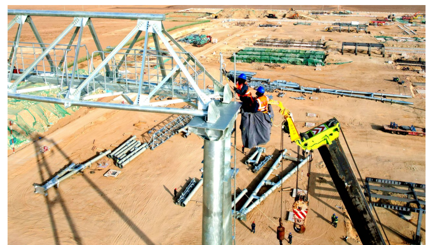
近日,位于利通区的星塘750千伏变电站新建工程现场,一根重约48吨的钢构梁精准落位,标志着工程项目正式迈入关键阶段。
