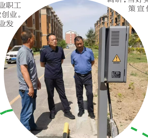
▲2025年6月，青铜峡市政协调研小区新能源充电桩安装使用情况。
