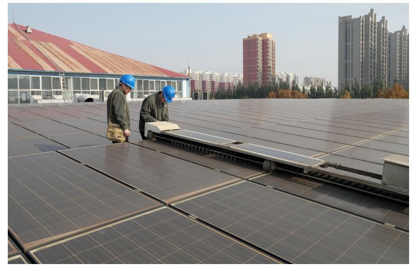
11月23日,工人在河北省保定市徐水区一家企业厂房屋顶上检修光伏发电板的清洁设备。
