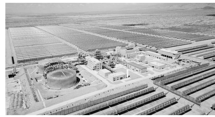
图为中广核德令哈5兆瓦光热发电示范项目。
