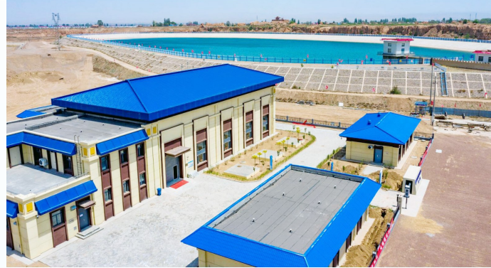
海原西安供水工程高压泵站。
