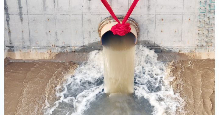
海原西安供水水源工程全线主管道及配水管线全部贯通。
