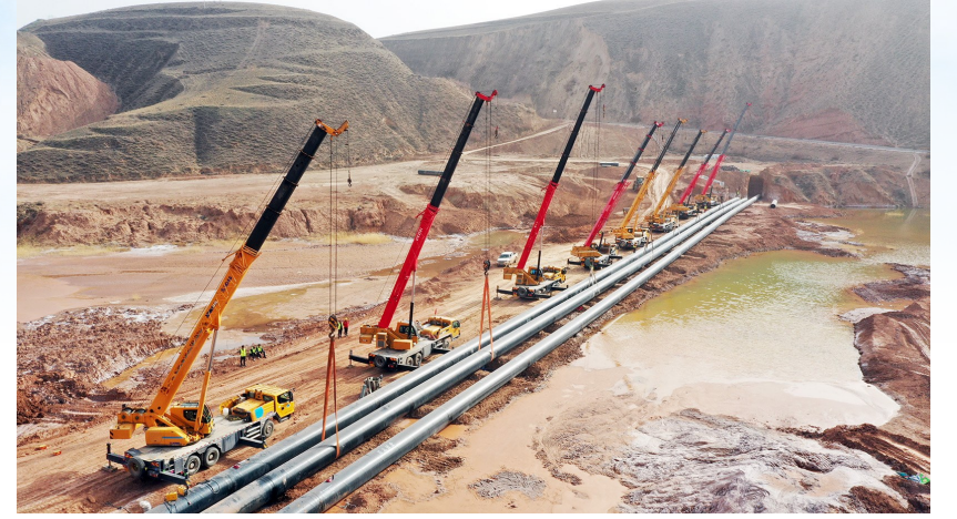
海原西安供水水源工程3号拉管段。
