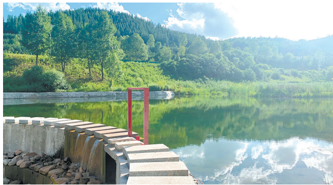
泾源县香水镇下寺村惠台片区综合治理工程。
