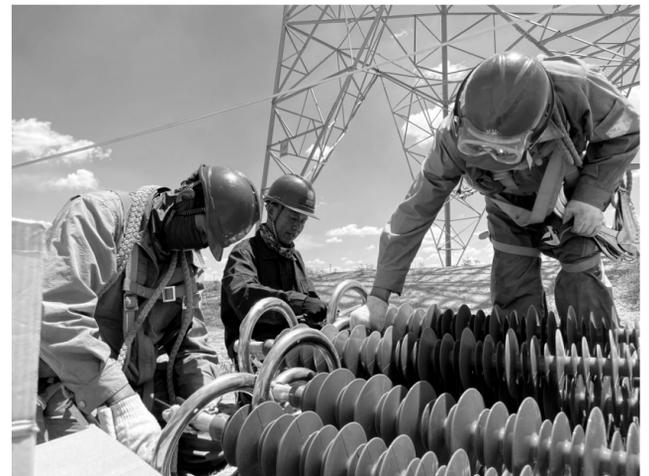
6月30日,在宁东煤化工基地附近,国网宁夏电力公司送变电工程有限公司电力工人在地表温度达到50℃的荒滩地上紧张施工。当日,330千伏汉州一二线检修工作以及更换光缆金具工作在这里启动。此次检修将有效解决宁东地区新增用电需求,预计到7月8日完工。在检修停电期间,为确保该条线路上用户用电不受影响,电力部门将330千伏汉州一二线上的用电负荷转接到330千伏灵州宋一二线、330千伏宋州一二线4条线路上。现场还设置了两个特巡保电小组,主要负责线路特巡工作,红外测温 and 交叉跨越测量等工作。本报记者 王斌 摄
