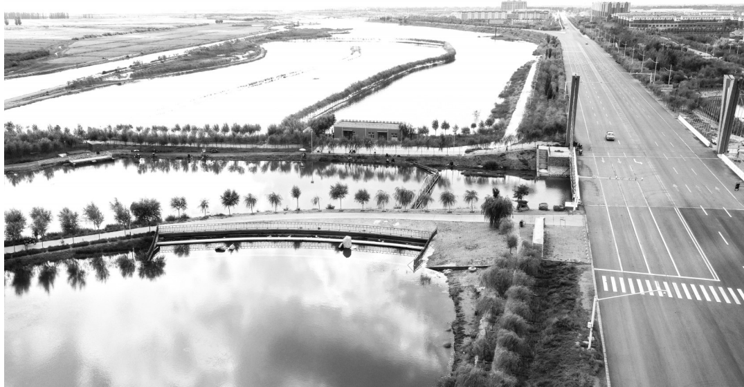
治理后的入黄排水沟石嘴山段。
