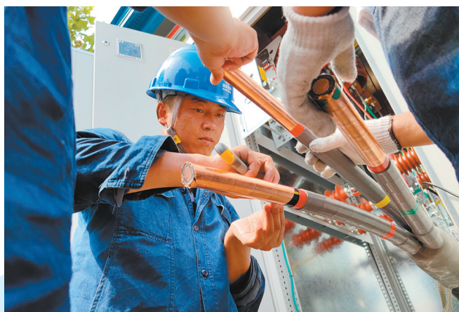
宁东供电公司的突击队员在敷设电缆。
