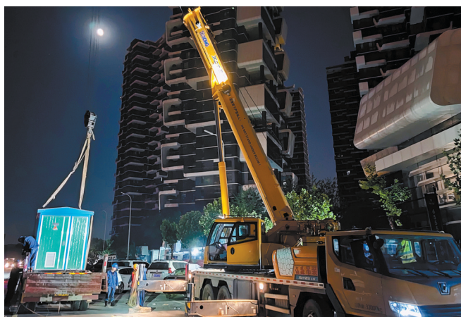
宁东供电公司的突击队员们连夜吊装配电设施。
