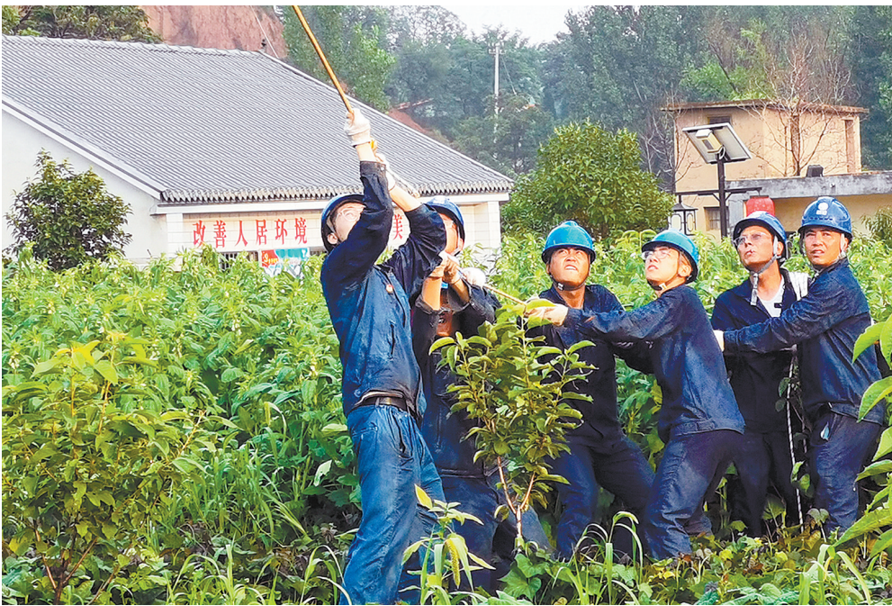
宁东供电公司的突击队员们冒雨正杆。
