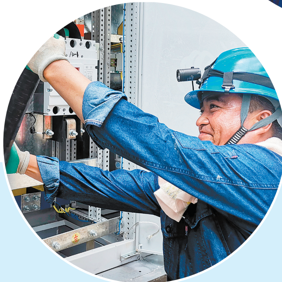
▼ 中卫供电公司的突击队员在对接电缆与变电器。
